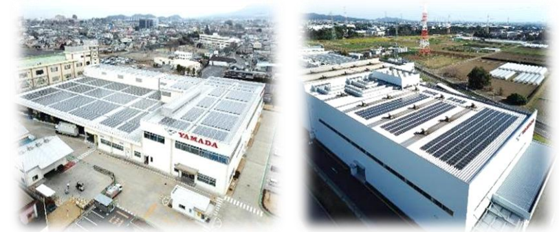
工場の屋根に太陽光パネルを設置
