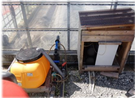
地下水くみ上げ灌水装置への設置
